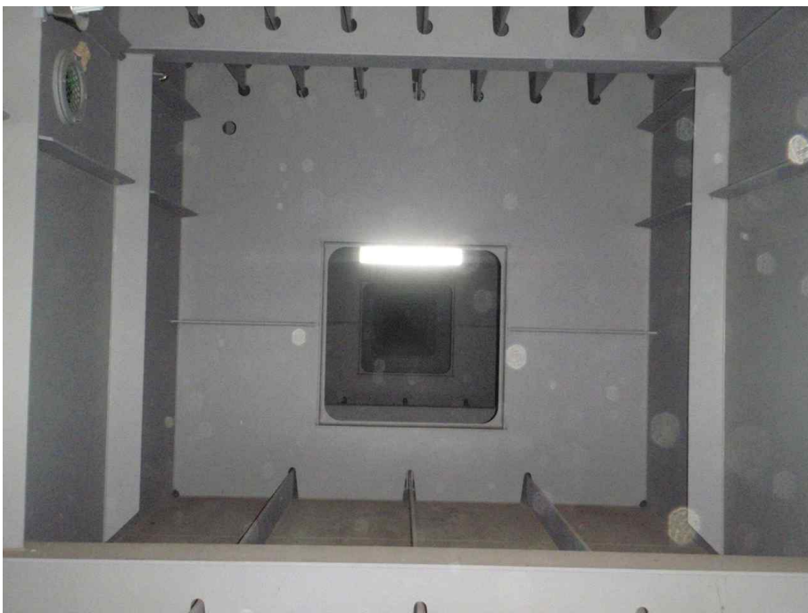
Steel Box Girder 내부 전경
