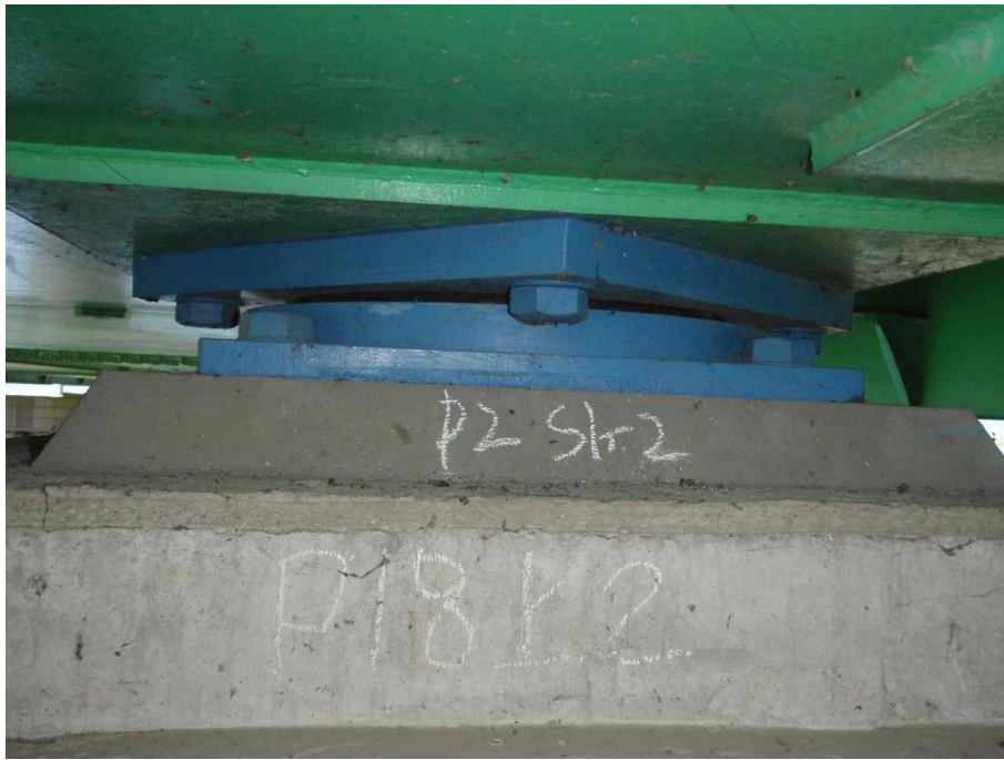
받침장치 전경 (고정단)
