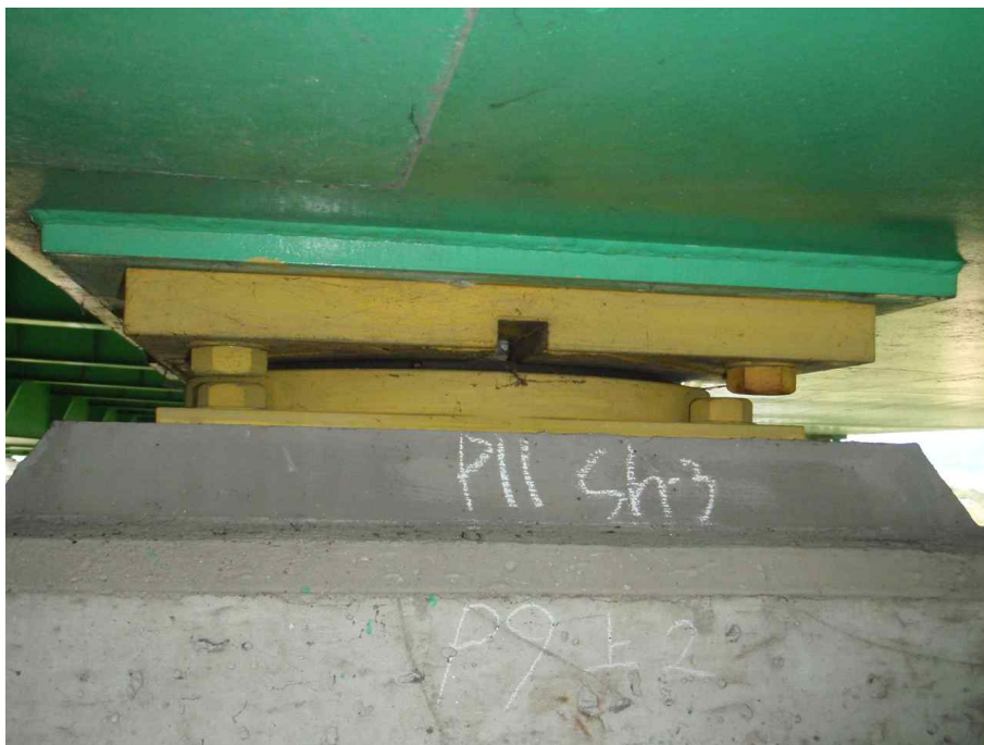
받침장치 전경 (가동단)
