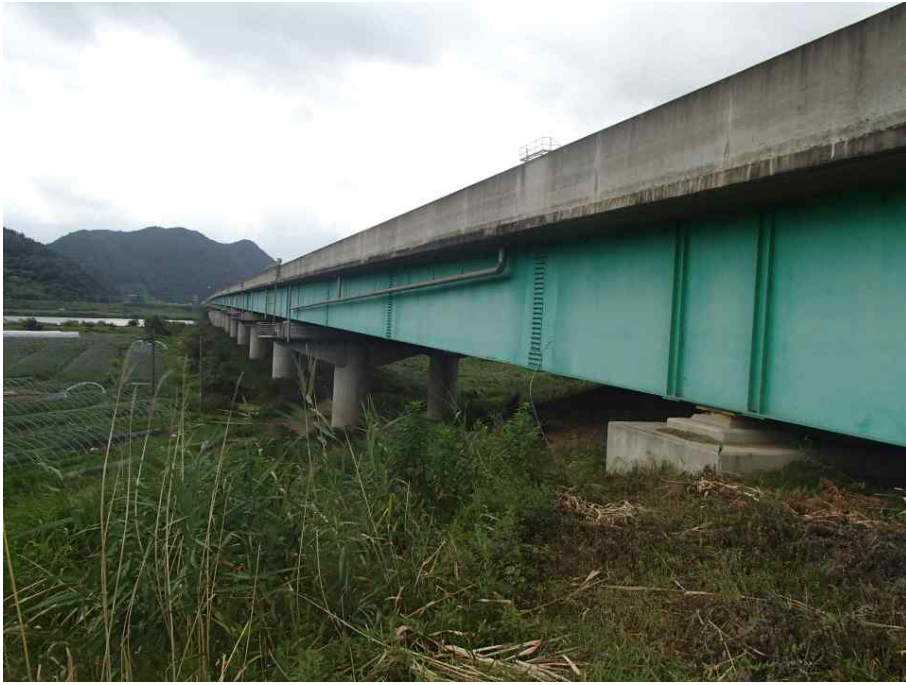
Steel Box Girder 외부 전경
